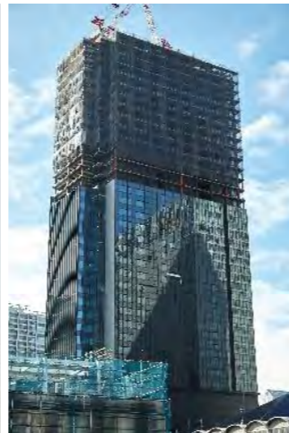
(南館建設の様子)
