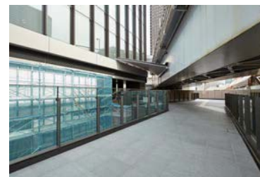
(南東デッキ②)
